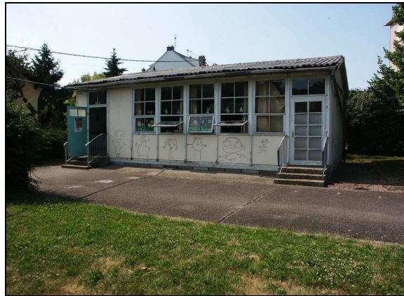
Ancienne classe passerelle
