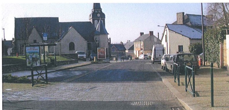
Un passage piéton bien identifié à proximité d'un arrêt de bus : marquage au sol durable, protection par des grilles (Chevaigné)
