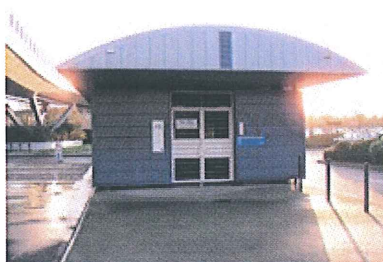
Parc à vélos sécurisé au parc-relais de la Poterie (Rennes)
