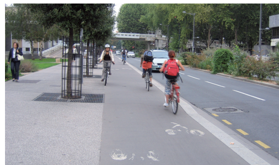
Piste contiguë à la chaussée
