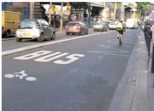
Au droit de l'arrêt bus, le couloir vélos-bus est fermé par un séparateur
