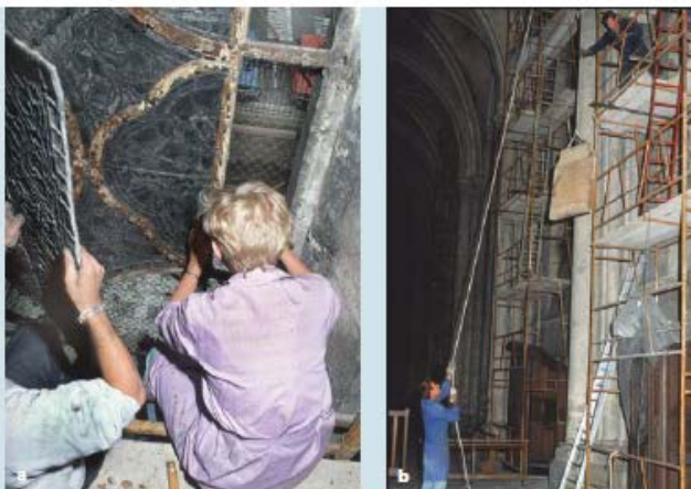
Chartres (28), cathédrale, a. Baie n° 42, dépose de panneaux par l'extérieur (©. LRMH). b. Transport de panneaux pour descente au sol dans un caisson vertical (©. LRMH).
