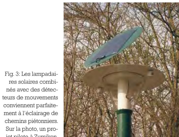
Fig. 3: Les lampadaires solaires combinés avec des détecteurs de mouvements conviennent parfaitement à l'éclairage de chemins piétonniers. Sur la photo, un projet pilote à Zumikon.
