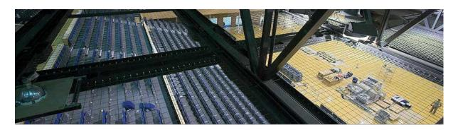
Il y a deux types de base du système Cablenet: le système à châssis simple qui implique la conception personnalisée d'un virtual floor® pour s'adapter à des formes, des tailles et spécifications non standards; et le système modulaire, dans lequel plusieurs grillages standards sont installés, un à un, afin de remplir l'espace requis
