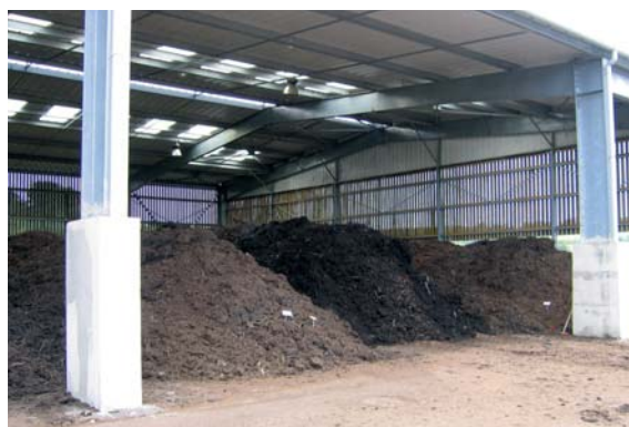
b) Andains sous hangar avec aération forcée – Plate-forme de co-compostage des boues urbaines de Pleyben (© Ademe Bretagne)
