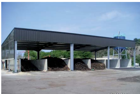
c) Silos de fermentation sous aération forcée – Plate-forme de co-compostage des boues urbaines de Lesneven (© Eaux de l'Ouest)
