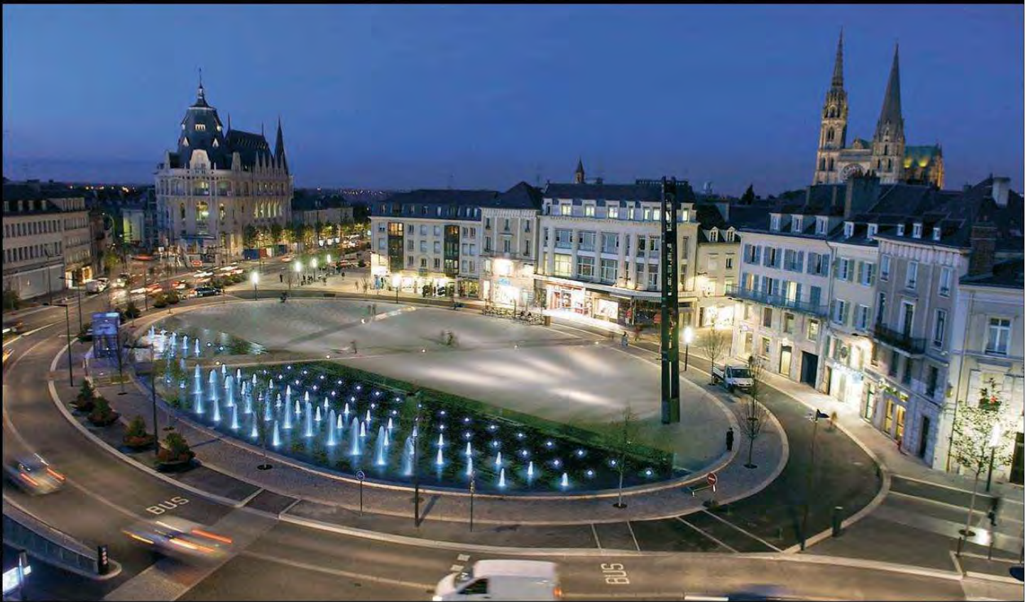
PLACE DES EPARS À CHARTRES La place est principalement éclairée à partir d'un mât unique de 18 m de haut supportant neuf projecteurs. Chacun des 96 jets d'eau est illuminé en contre-plongée à partir de quatre appareils immergés (IP 68) équipés chacun d'une LED intensive à haut rendement. Paysagiste, Jacqueline Osty ; architecte, Reichen & Robert ; concepteur lumière, Roger Narboni/agence Concepto ; matériels d'éclairage, Aubrilam, LEC, Thorn.
